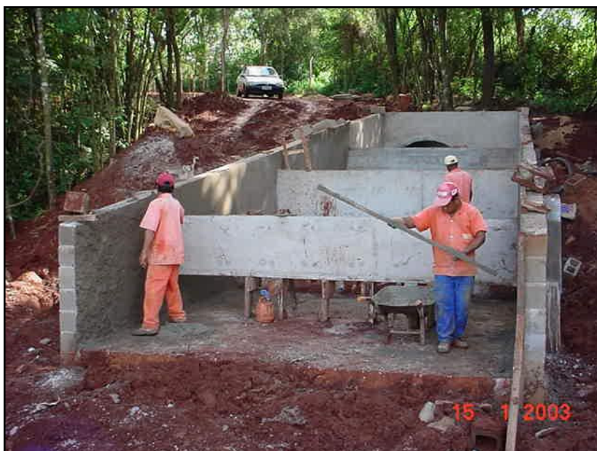
Foto 08: Execução de escada hidráulica.
