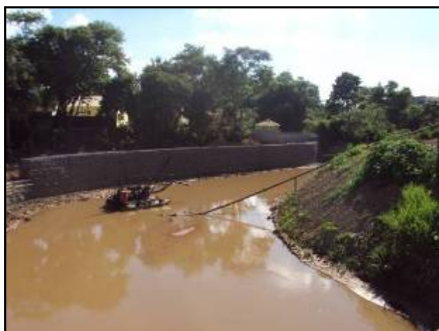
Figura 4.3.3.1.2-12: Dragagem do leito do rio para desassoreamento.
