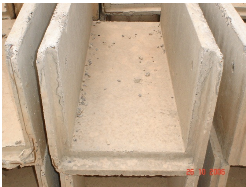
Foto 10: Canaletas pré-moldadas.
