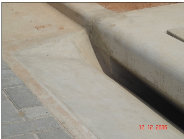
Foto 05: Detalhe da inclinação da sarjeta para captação das águas.
