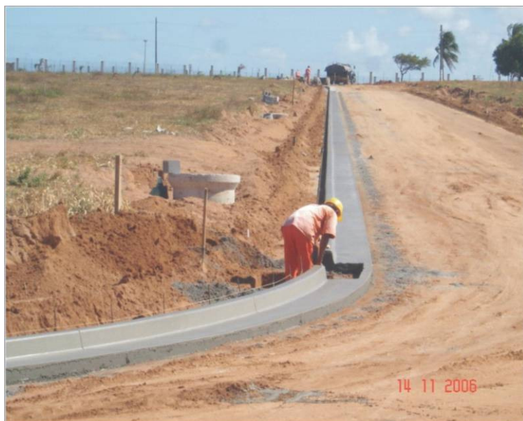
Foto 03: Acabamento de guia com abertura para boca de lobo.
