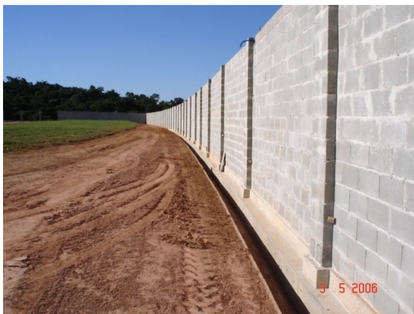
Foto 14: Acabamento da execução das canaletas de pé de muro.
