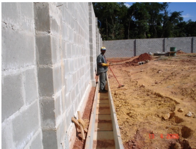
Foto 11:Execução das canaletas pré-moldadas.
