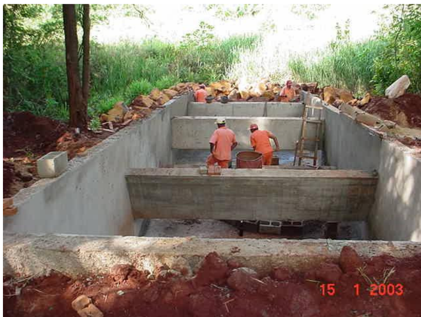
Foto 09: Execução de escada hidráulica.
