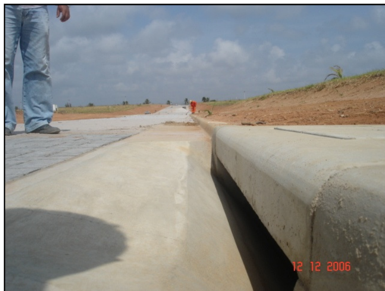
Foto 07: Detalhe de declividade longitudinal da sarjeta.
