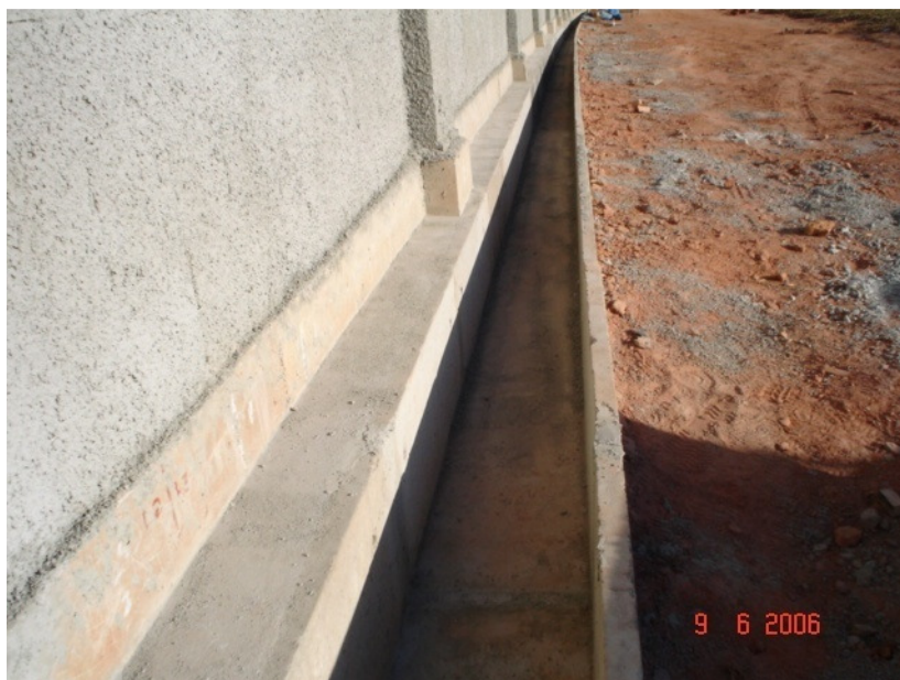
Foto 13: Detalhe locação muro e canaleta.
