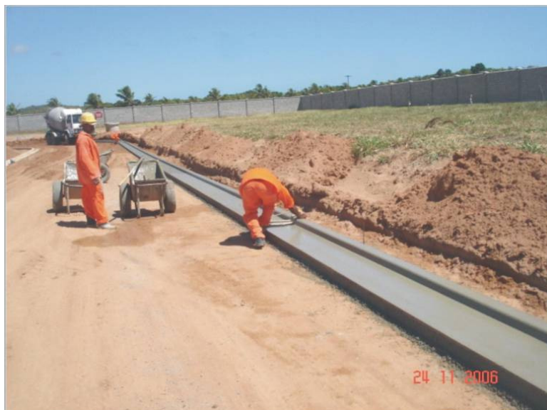
Foto 02: Execução de guia e sarjeta extrusada
