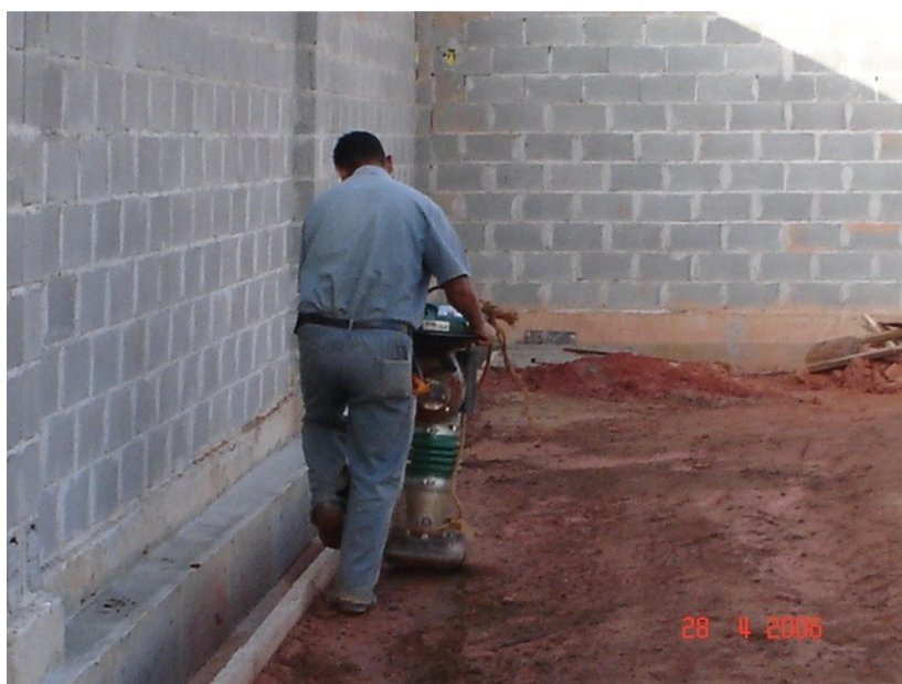
Foto 12:Execução da compactação próximo as canaletas pé de muro.
