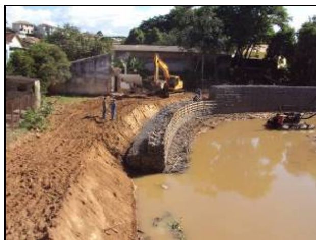
Figura 4.3.3.1.2-13: construção de sistema de contenção das margens do rio.
