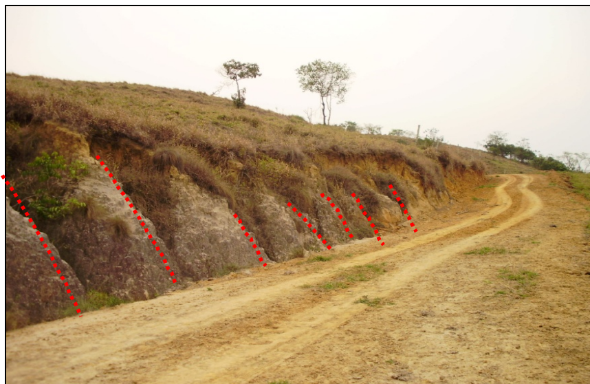
Figura 4.3.1.5.2-5: Setor de encosta convexo-retilínea no setor centro-sul da área de estudo, onde predominam processos erosivos de cunha linear, representados neste caso, pela instalação de pequenos sulcos erosivos (linhas pontilhadas em vermelho) nas bordas do talude de corte da estrada.
